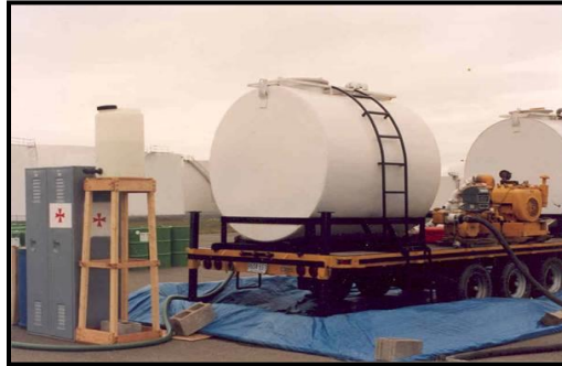
Figure 2.1 Citerne mobile dans un aménagement de rétention
